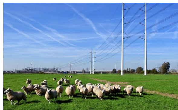
Figuur 2. Onderdeel van de hoogspanningskabels
