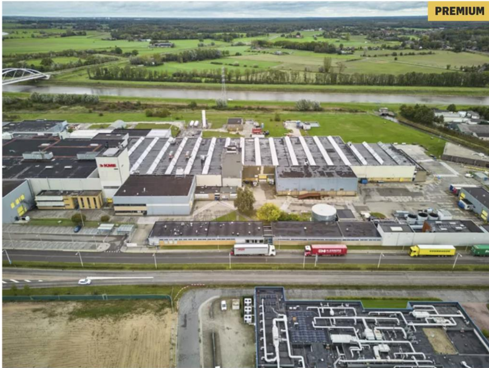
▲ Op de braakliggende grond achter KME, dus aan het Twentekanaal, komt de waterstoffabriek te staan. © Arjan Gotink
