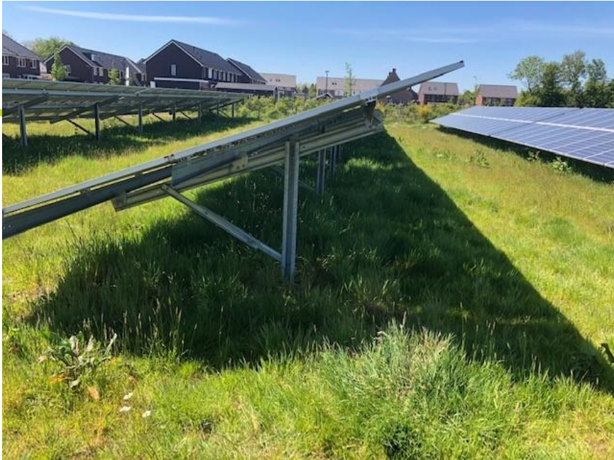
Solarpark de Kwekerij, Hengelo
