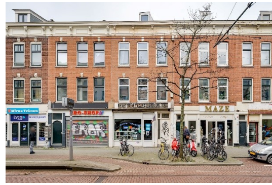
VvE met utiliteitsbouw
